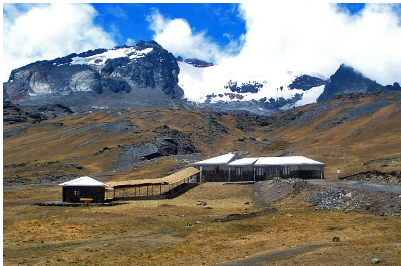
Figura No. 14: Infraestructura construida por el proyecto
