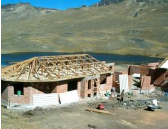
Albergue en Construcción
