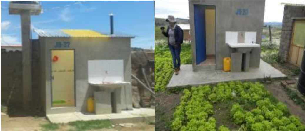
Fotografía 2. Módulos Sanitarios Ecológicos
