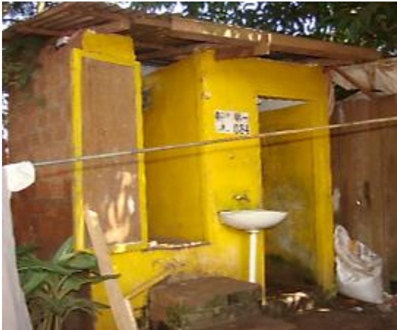
Fotografía 9. Baño ecológico construido en 2013
