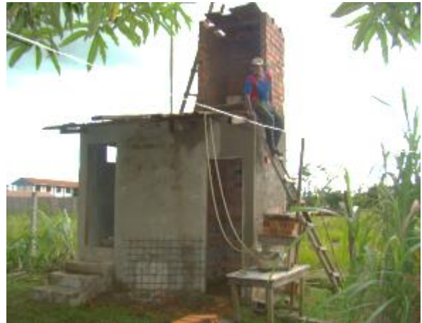
Fotografía 4. Construcción de un módulo con tanque de agua
