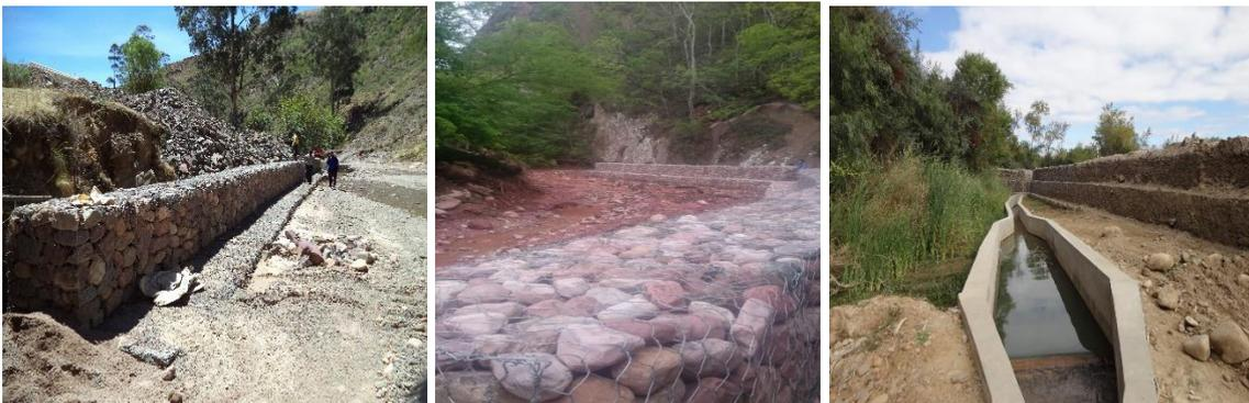
Diques de contención y protección de la fuente de agua donde se instala la obra de toma.
