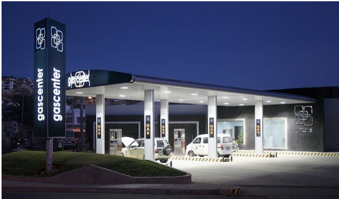
Ilustración 3 Estación de Servicio GAS CENTER I
